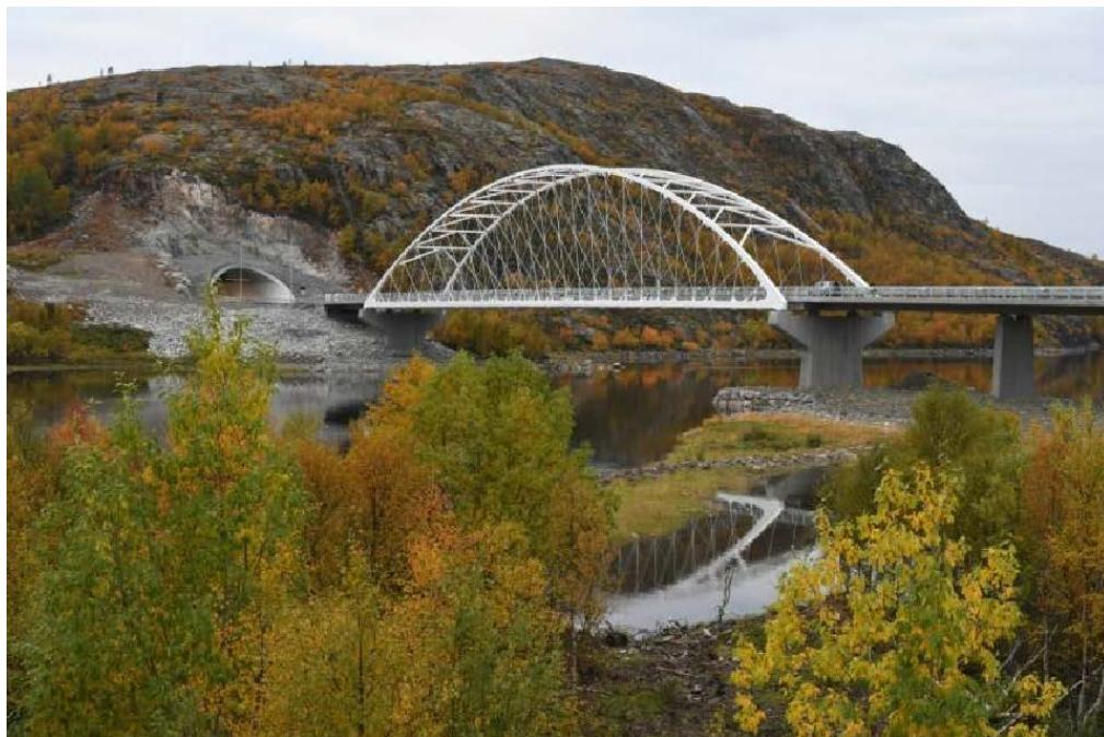
Døme på nettverksbogebru som går over i ei platebru, Bøkfjordbrua (kjelde; vegvesen.no; foto Knut Opeide). Brudtype og detaljert utforming av bruva vil bli vurdert i det vidare planarbeid.
